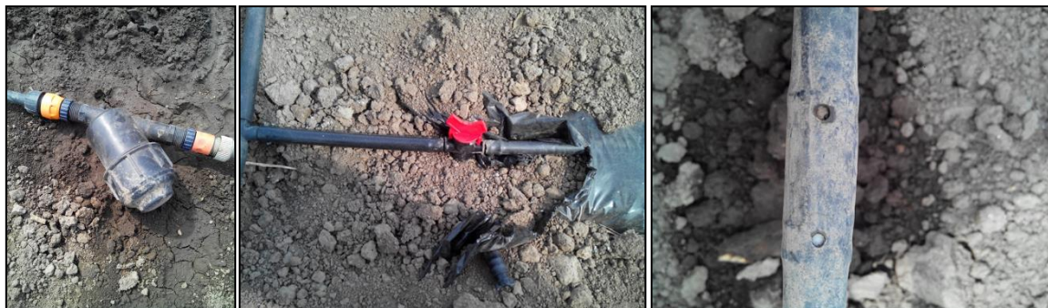
Obrázok 3 Závlahová sústava, ostatné komponenty – diskový filter Azud, ventil sekcie, detail hadice
