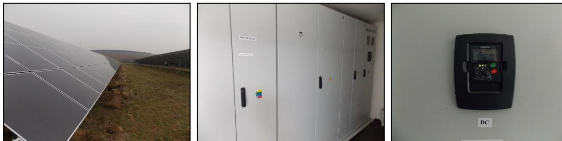
Obrázok 2 Panely Heliosphaera HS 110, Menič Vacon, Informačný display
