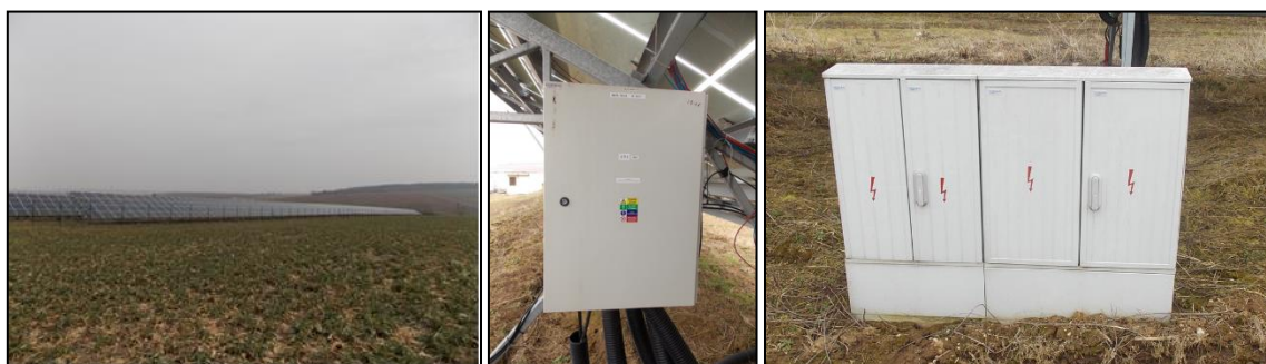
Obrázok 1 FVE, Box max, rozvádzač
