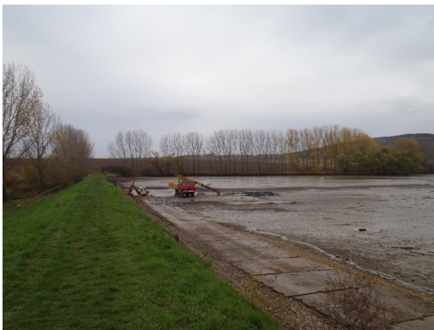
Obr. 4.11 Zemná hrádza malej vodnej nádrže v Koliňanoch (Foto: Jurík)
