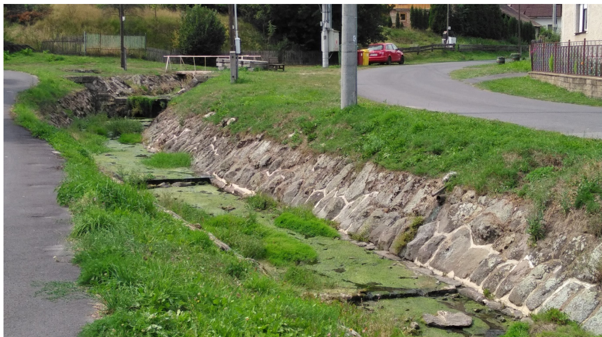
Obr. 6.10 Jednoduchý lichobežníkový profil koryta vodného toku s priečnymi objektmi v dne toku (Foto: Kaletová)
