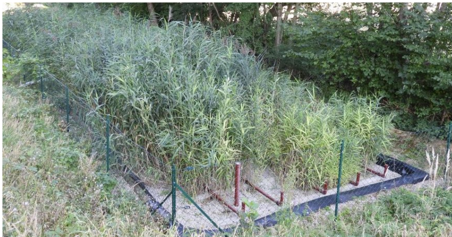
Obr. 4.6 Vegetačná koreňová čistiareň s vertikálnym prúdením (Foto: Jurík)
