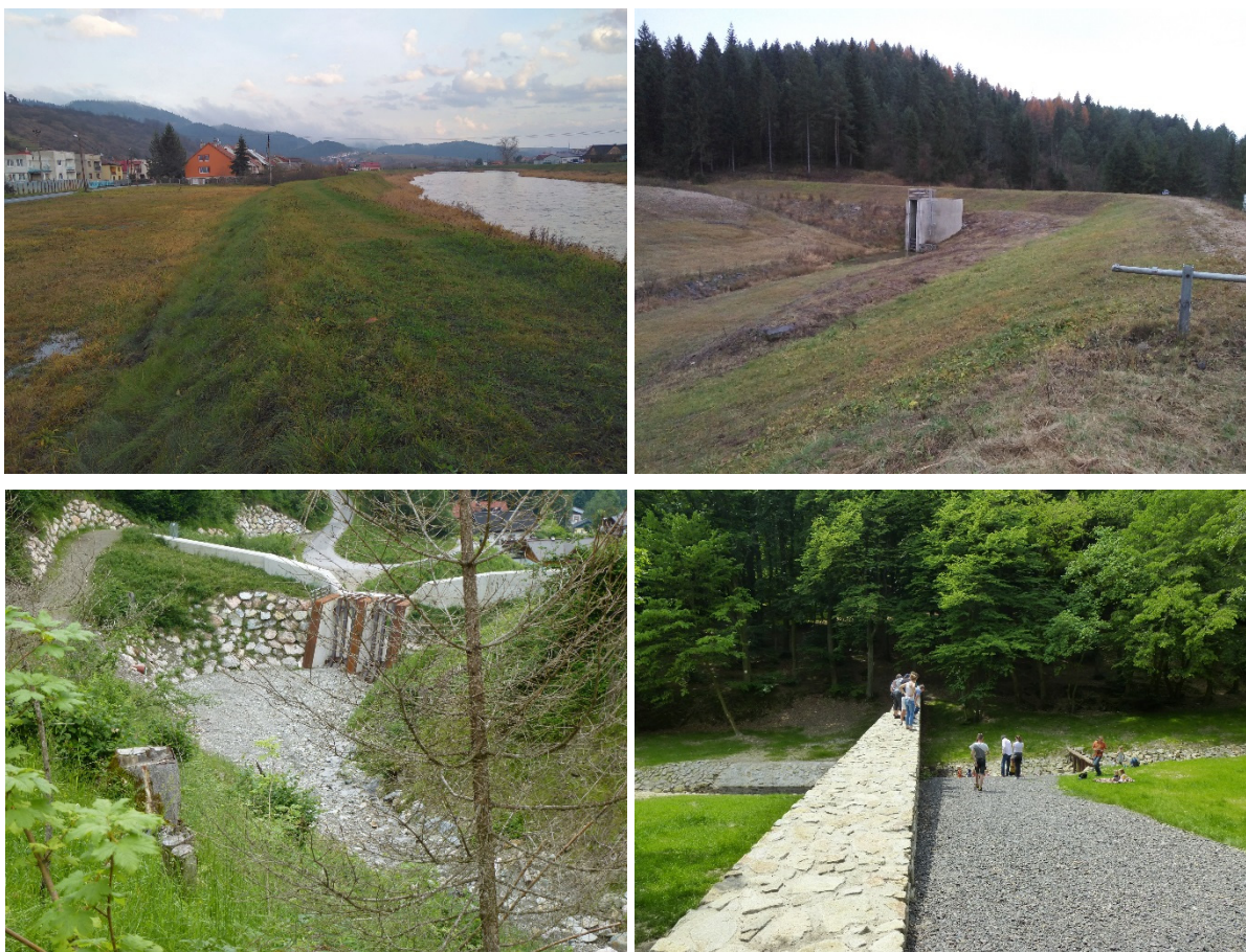
Obr. 1.9 Protipovodňové opatrenia - ochranná hrádza (vľavo hore), polder (vpravo hore), štrbinová prehrádzka (vľavo dole) a betónová prehrádzka (vpravo dole) (Foto: Kaletová)
