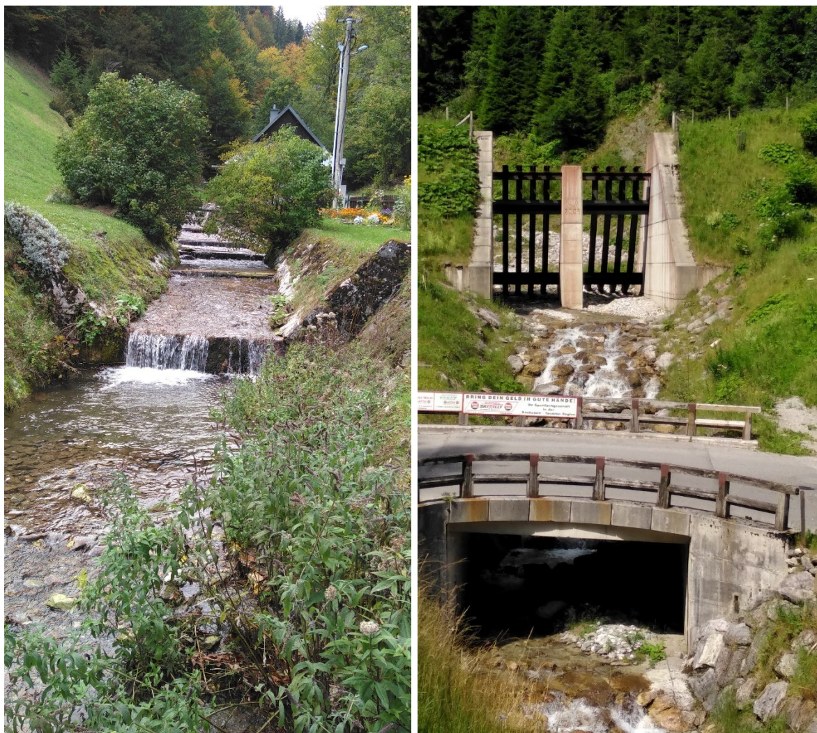
Obr. 6.11 Objekty na vodných tokoch; prahy (vľavo), most a prehrádzka (vpravo) (Foto: Kaletová)
