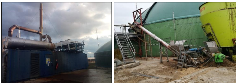
Obrázok 6 Kontajner KGJ TEDOM Bps Trakovice a šikmý závitkový dopravník
