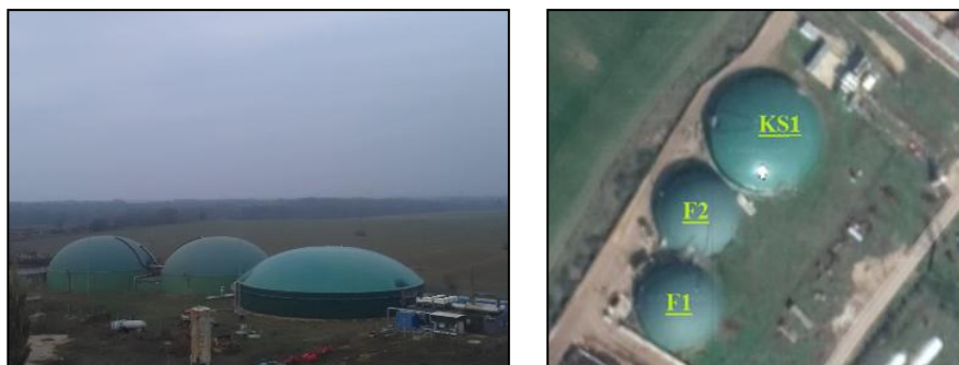
Obrázok 3 Detail bioplynovej stanice s popisom, F1-Hlavný fermentor; F2-dofermentor; KS1-koncový sklad
