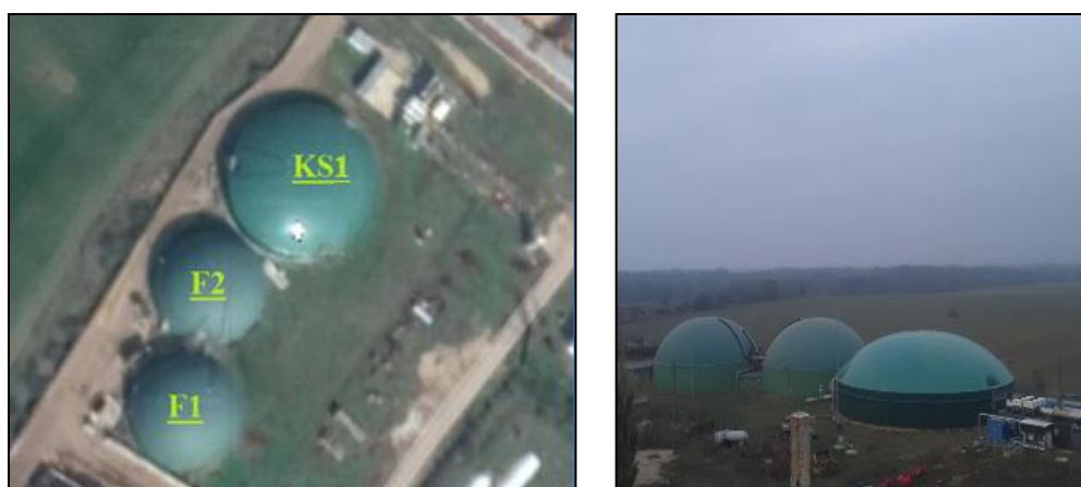
Obrázok 5 Detail bioplynovej stanice s popisom, F1-Hlavný fermentor; F2-dofermentor; KS1-koncový sklad
