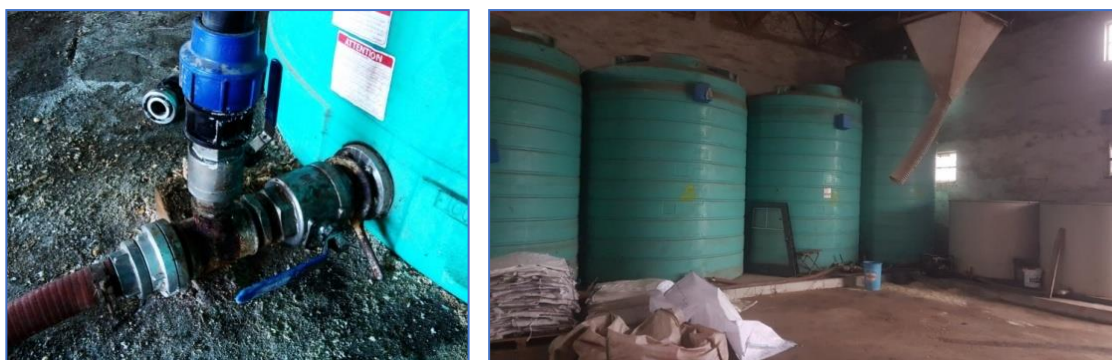
Obrázok 3 Technologické riešenie pripojenia nádrže, Zásobníky pre tekuté hnojivo – Lupol, s.r.o.
