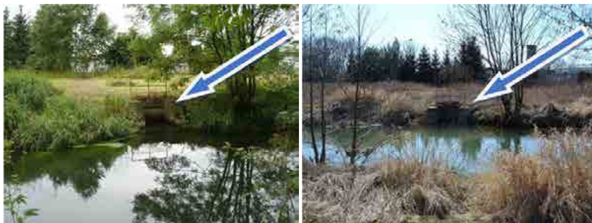
Obr. 17 (vlevo) Stav 6/2016. OP 2, Obr. 18 (vpravo) Stav 4/2012. OP 2
